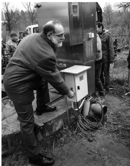
A polgármester ünnepélyesen elfordítja a szivattyú kapcsolóját
