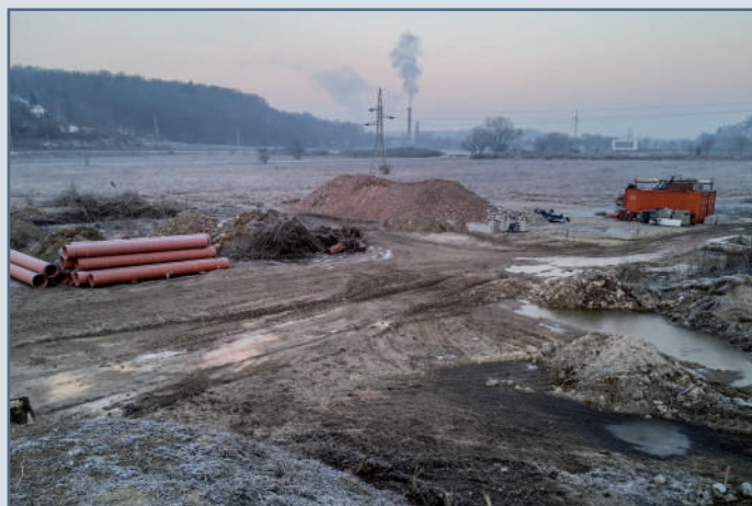
Megkezdődött az ürömi körforgalom építése
